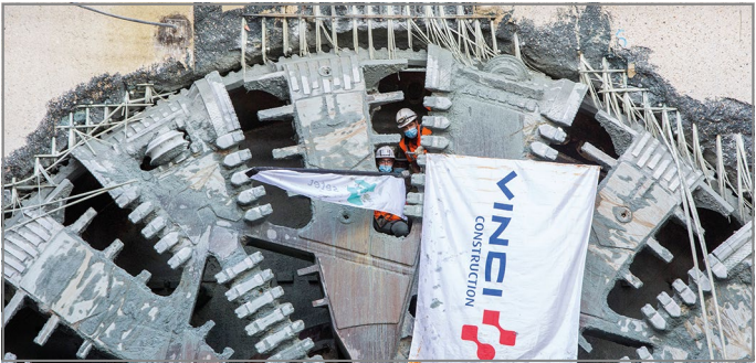
Abb. 4: Die mit Combar® bewehrte Schlitzwand wird mit der Tunnelbohrmaschine nahtlos durchfahren.
