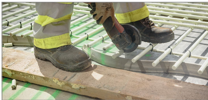
Abb. 3: Leichte Zerspanbarkeit von Combar® unter Querdruck
