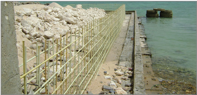
Abb. 10: Aufgrund der marinen Umgebung mit Salzwasser, hohen Temperaturen und hoher Luftfeuchtigkeit wurde bei der Bewehrung der Stützmauer der Seafront Villa Qatari in Doha die Glasfaserverbundbewehrung Combar® eingesetzt.
