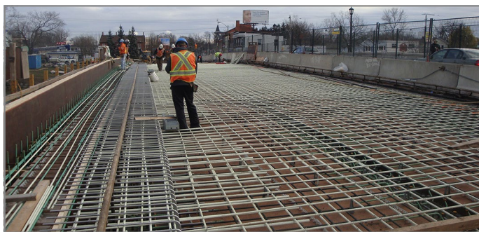
Abb. 9: Combar® Bewehrung der Weightman Bridge, Niagara Falls, Ontario, Canada
