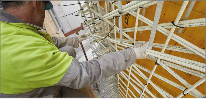
Abb. 11: Der Bauherr, Stahlhändler L. Klein AG, legte viel Wert auf ein gesundes Arbeitsumfeld und wünschte keine Stahlbewehrung. Der Ingenieur schlug den Glasfaserverbundwerkstoff Combar® vor.
